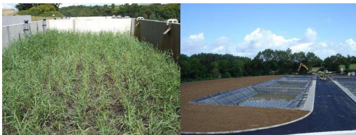
Figure 19 : Exemples de lits de séchage béton et en déblai-remblai
