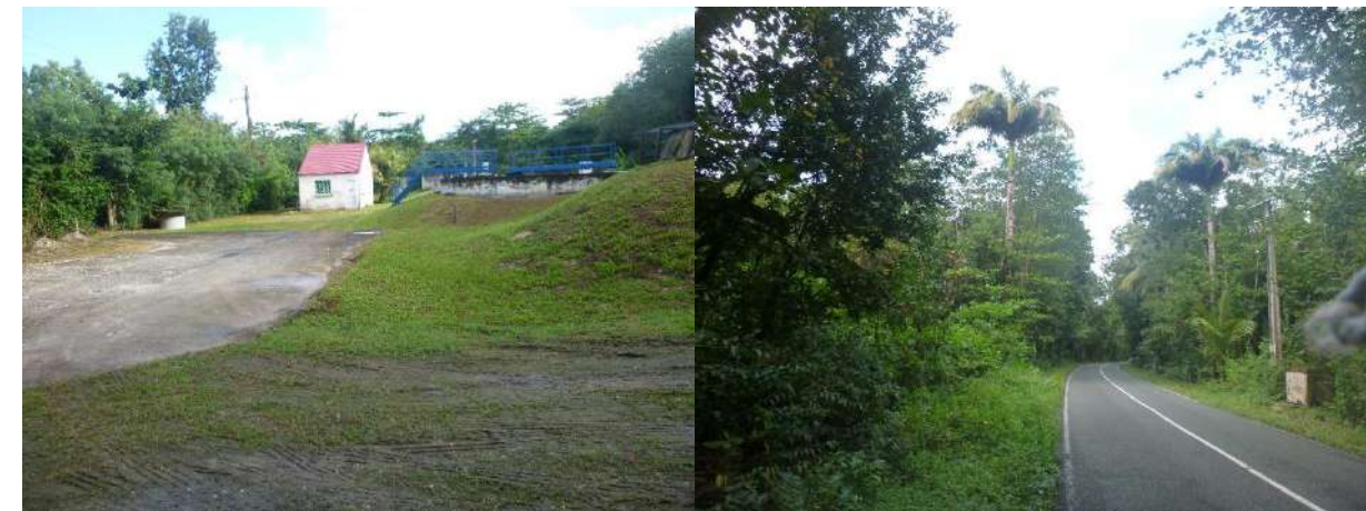
Station d'épuration de Folle Anse ; RD206 et alignement de Palmier royal au droit de la STEP
