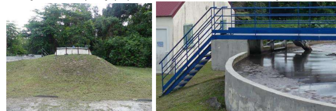
Figure 16 : clichés photographiques du bassin d'aération et du silo de stockage des boues
